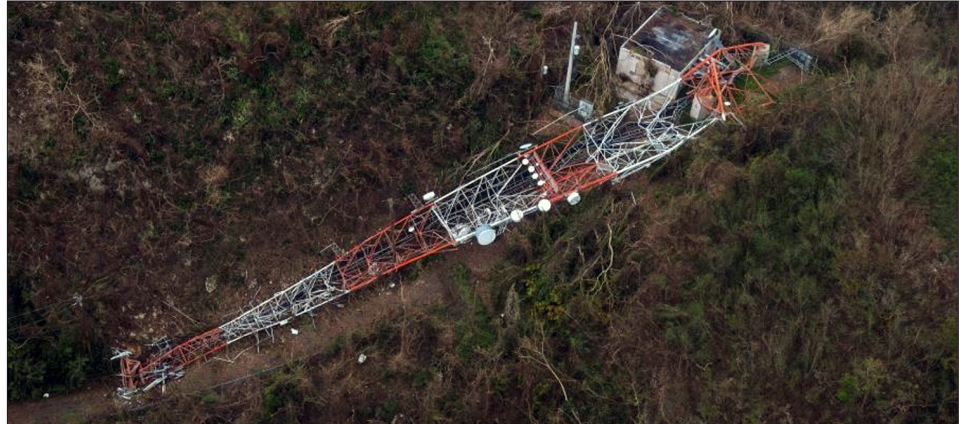
Vista aérea de una torre caída en Puerto Rico después del huracán María, septiembre de 2017
