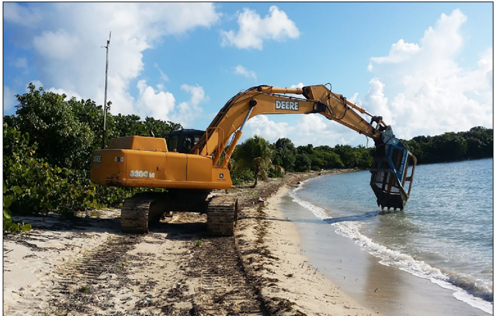
Figura 10: Excavadora operada por control remoto que se usa en los sitios de limpieza de Vieques, Puerto Rico
