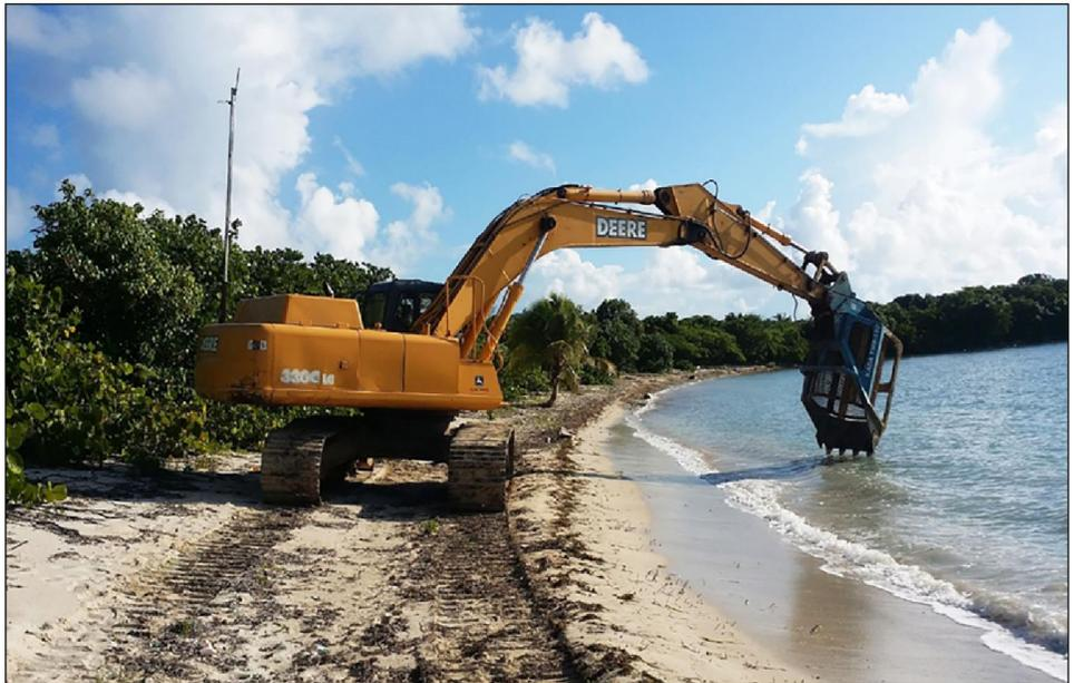
Una excavadora operada por control remoto criba arena en un sitio de limpieza en Vieques, Puerto Rico.
